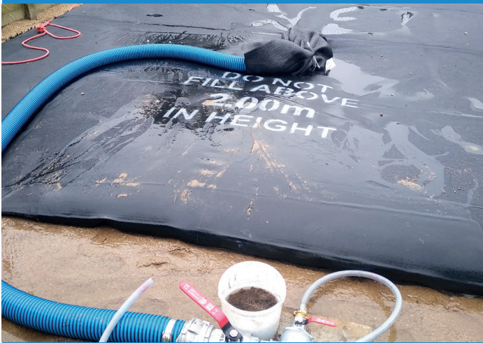
TenCateGéotube® dewatering
